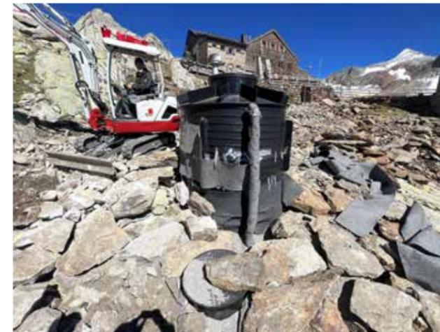
Noch nicht vollständig „verkleideter“ Tropfkörper-Behälter für die Abwasserreinigung
