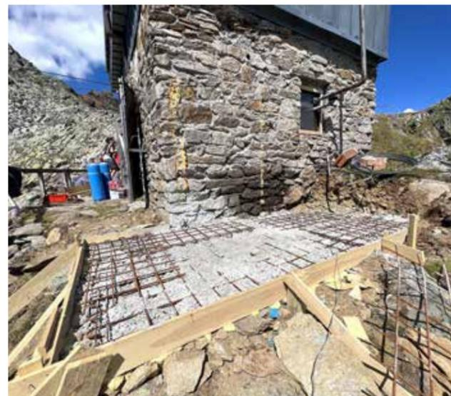
Untergrundherstellung für die kommende Feinschlammabtrennung
