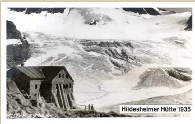
3. Ausbaustufe, nach 1923, seitlicher Anbau sowie Belastungspfeiler
